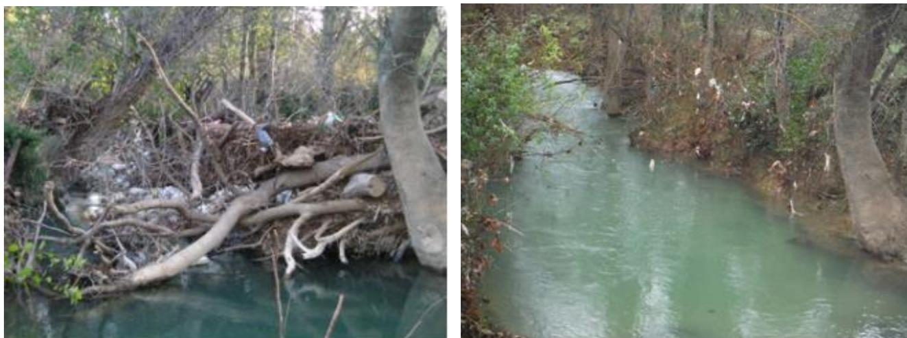
**Figure 35. Travaux de désembâclement avant après sur la Mosson (source : EPTB Lez, 2010).**
